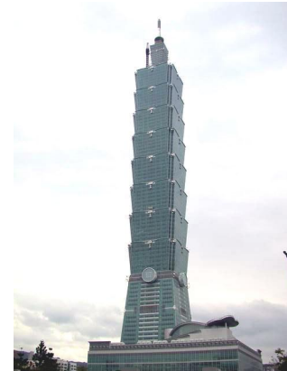
Abbildung 1 Das Taipei Financial Center (Taipeh 101) in Taiwan ragt mit einer Höhe von 508m in den Himmel. Bei einem Taifun kann seine Spitze bis 1.3m hin und her schwingen! Quelle: Wikipedia
