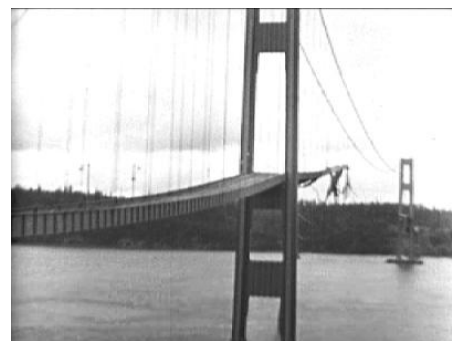
Abbildung 16 Tacoma Narrows Bridge nach ihrem Einsturz am 7. November 1940. Quelle: Wikipedia
